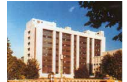
研究棟竣工（昭和56年）
