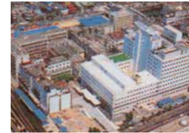
外来診療棟竣工(昭和53年)
