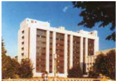
研究棟竣工（1981年）
