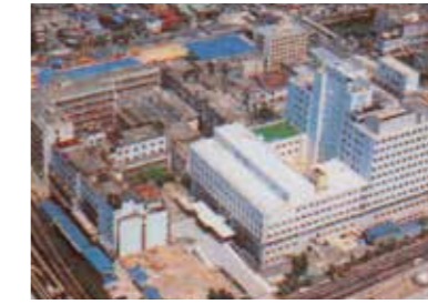
外来診療棟竣工 (昭和 53 年)
