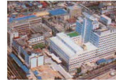
外来診療棟竣工 (昭和53年)
