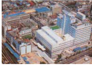
外来診療棟竣工（昭和53年）
