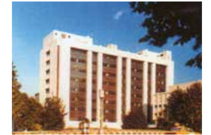
研究棟竣工（昭和56年）
