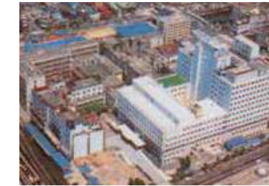
外来診療棟竣工(昭和53年)
