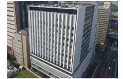
研究棟新棟竣工(2017年)
