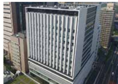
研究棟新棟竣工（2017年）
