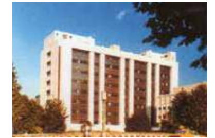
研究棟竣工(昭和56年)
