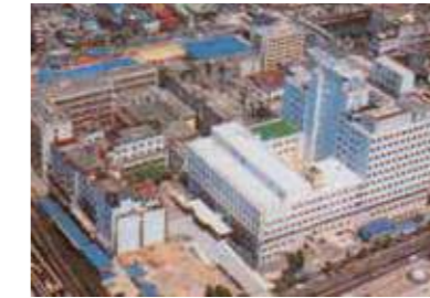
外来診療棟竣工(昭和53年)
