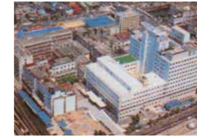
外来診療棟竣工（昭和53年）
