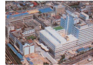
外来診療棟竣工（昭和53年）
