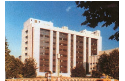
研究棟竣工（昭和56年）
