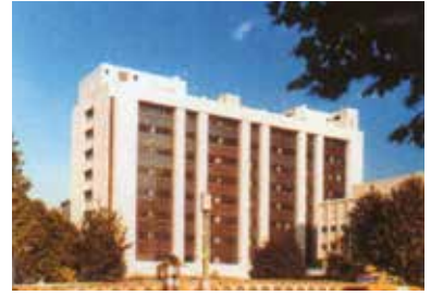
研究棟竣工（昭和56年）
