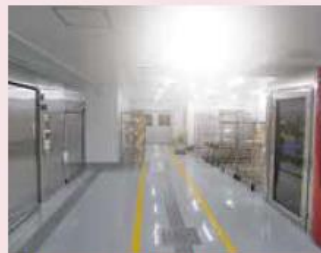
大型滅菌装置(左)密閉型自動ケージ洗浄機(右) (動物実験・洗浄室)
