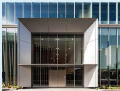
北東側エントランス
